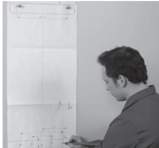
1. Предварительная разметка с помощью монтажного шаблона
